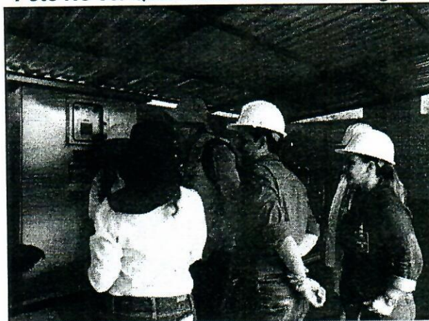
Foto No 35. Quemador cerrado de biogás
