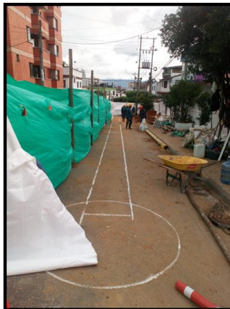
REPARACION BARRIO ALVAREZ CALLE 34 CARRERA 40
