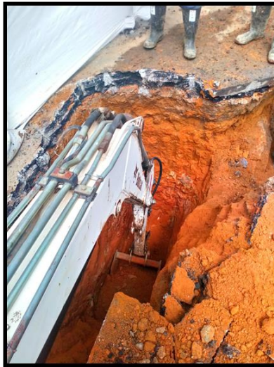
REPARACION BARRIO ALVAREZ CALLE 34 CARRERA 40
