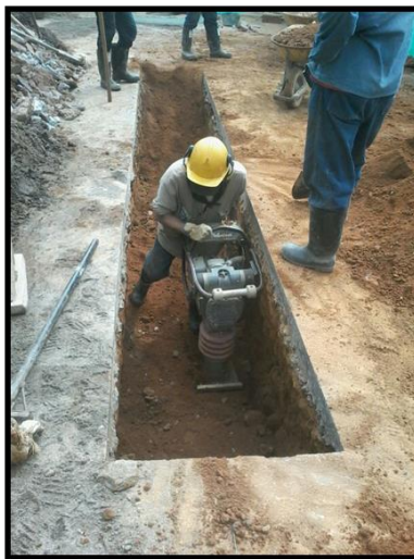
REPARACION BARRIO ALVAREZ CALLE 34 CARRERA 40
