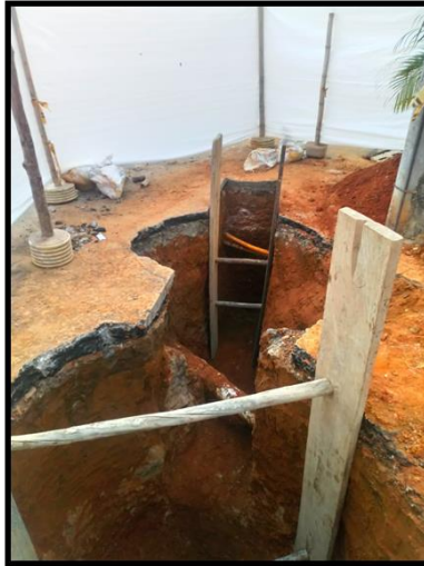
REPARACION BARRIO ALVAREZ CALLE 34 CARRERA 40
