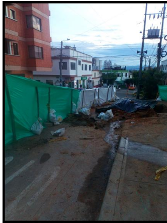
REPARACION BARRIO ALVAREZ CALLE 34 CARRERA 40
